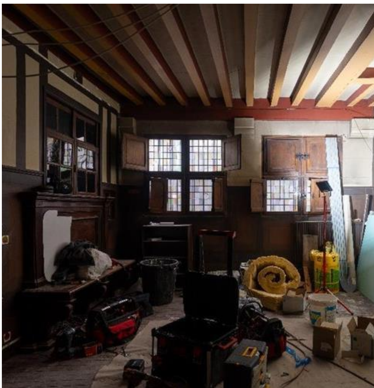
Travaux de rénovation de la maison natale Pierre Corneille, 2025 © MRN / Guillaume Brière Soude
